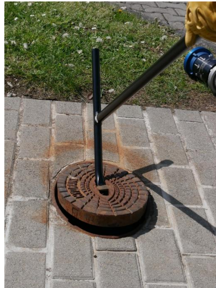
6.5.2-2 Abheben des Straßenkappendeckels
