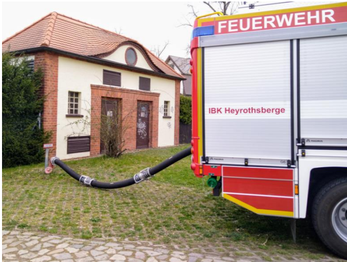
6.4-1 Wasserentnahme mittels Saugschläuchen aus Löschwasser- Sauganschluss
