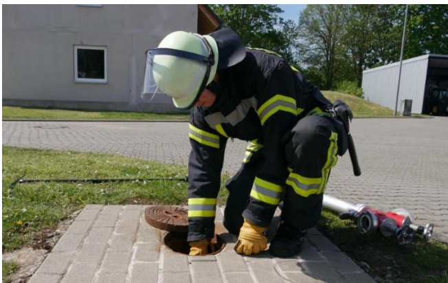
6.5.2-3 Kontrolle des Unterflurhydranten auf Verschmutzung
