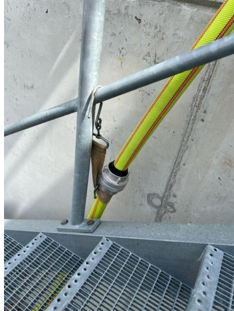
4.6-2 Entlastung der Schlauchleitung mittels eines Schlauchhalters
