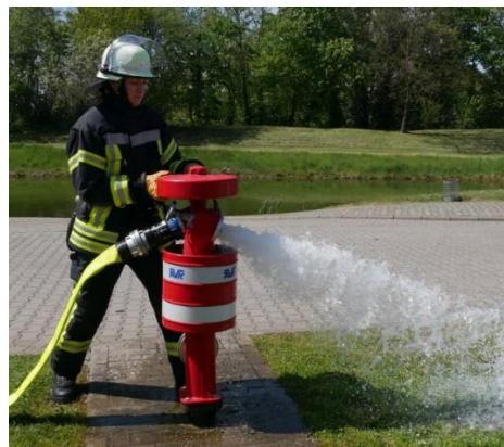
6.5.3-2 Spülen des Fallmantelhydranten
