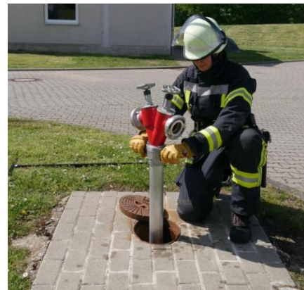
6.5.2-4 Einsetzen des Standrohres
