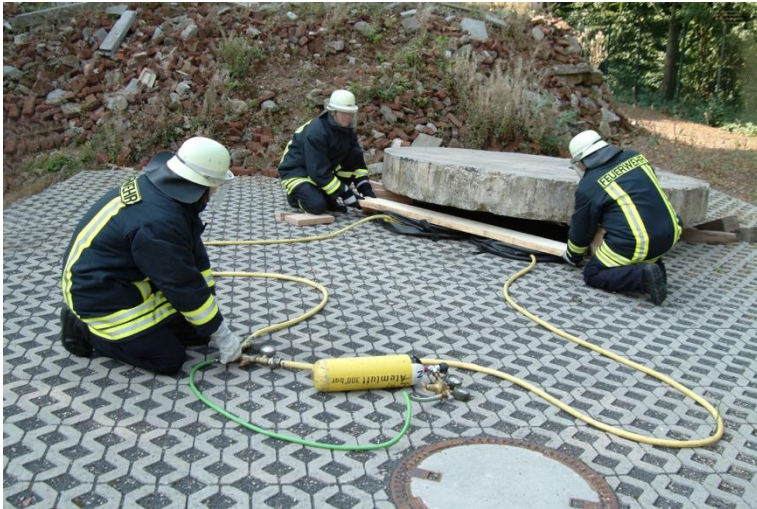
12.2.1-1 Hebekissensystem bis 1 Bar
