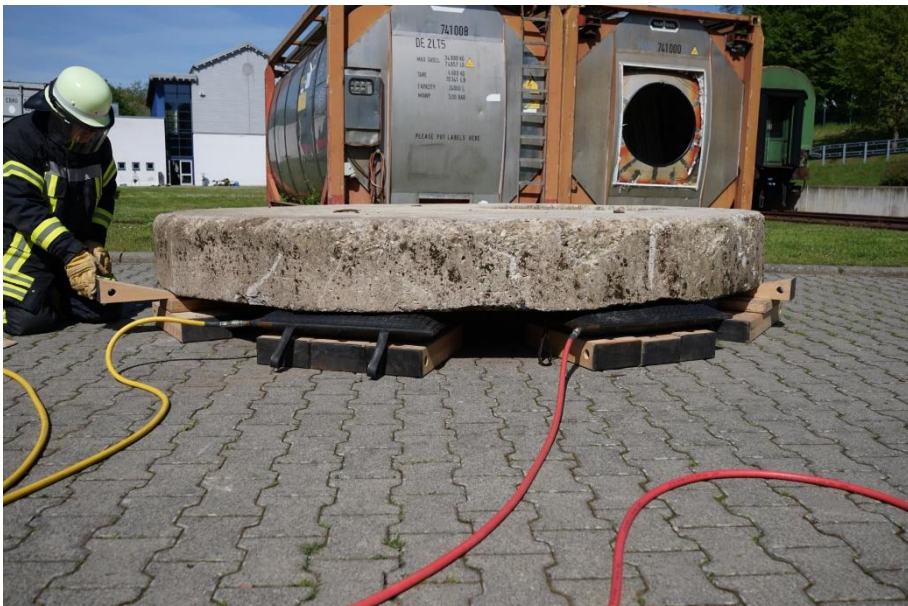
12.2.2-4 Hebekissensystem über 1 Bar beim Heben einer Last - nebeneinander angeordnet
