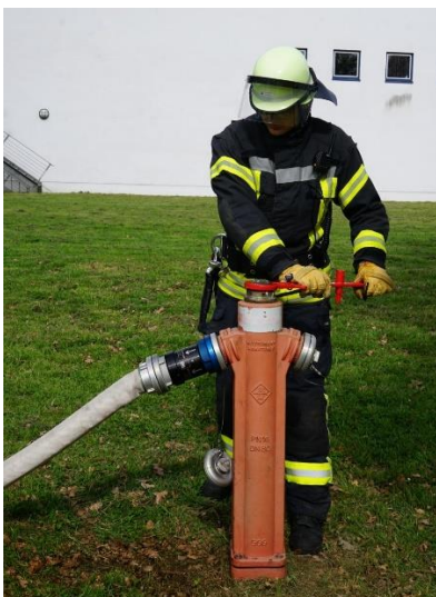
6.5.3-5 Erneutes Öffnen des Überflurhydranten nach dem Kommando „Hydrant - Wasser marsch!“
