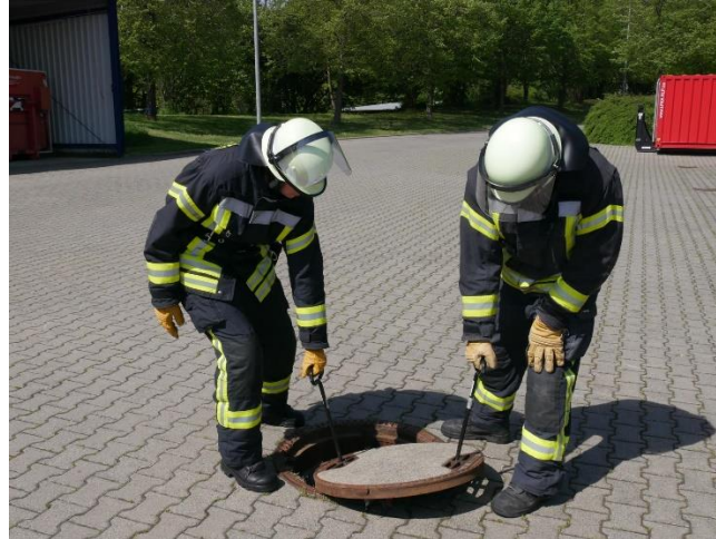
6.3-2 Öffnen des Saugschachtes durch zwei Einsatzkräfte
