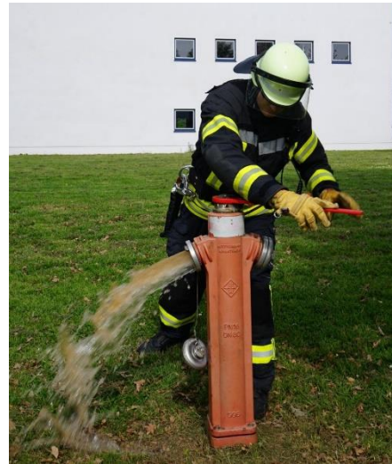
6.5.3-4 Spülen des Überflurhydranten
