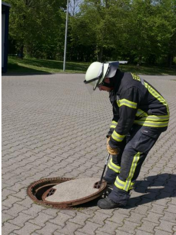
6.3-1 Öffnen des Saugschachtes durch eine Einsatzkraft
