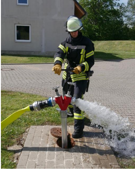
6.5.2-6 Spülen des Unterflurhydranten
