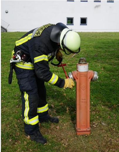
6.5.3-3 Entfernen der Deckkapsel
