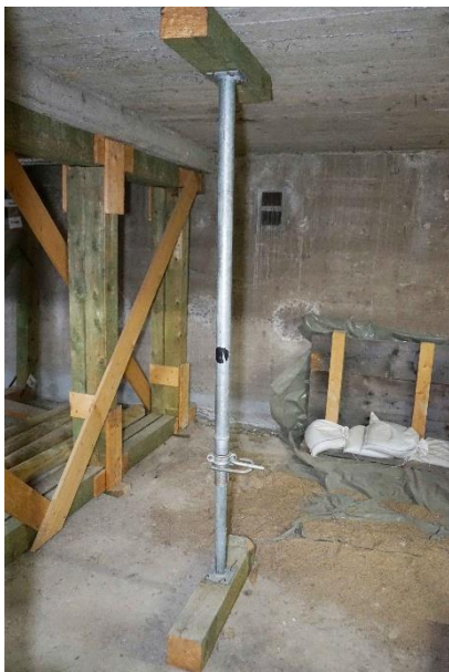
16.4.3-1 Baustütze mit Rüstholz
