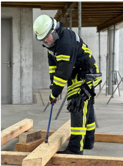
8.3-1 Ziehen von Nägeln mit dem Nageleisen
