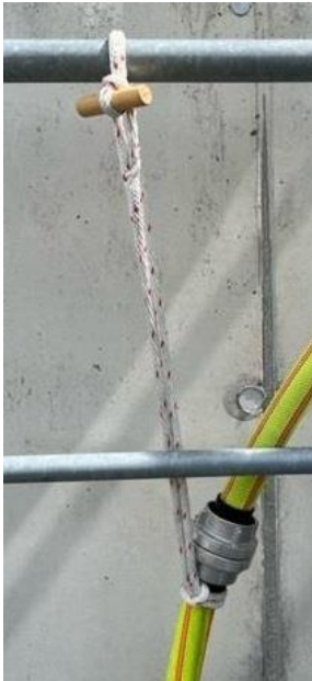
4.6-1 Entlastung der Schlauchleitung mittels eines Seilschlauchhalters
