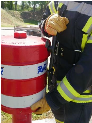
6.5.3-1 Lösen des Fallmantels
